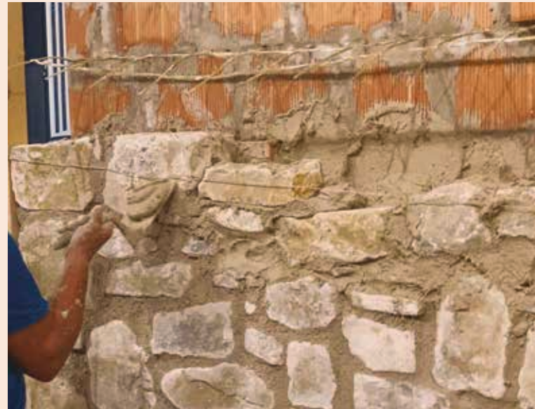
Fase di costruzione in cantiere
