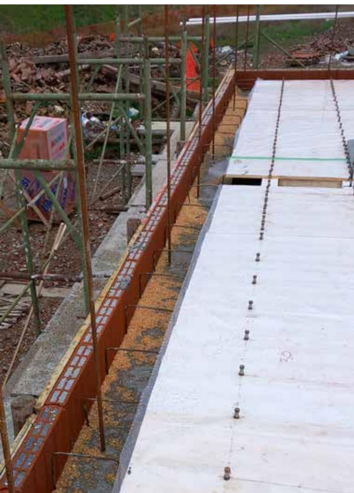
La tramezza con isolamento interposto a correzione del ponte termico del cordolo.
