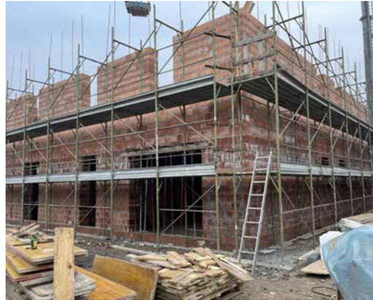
Lo stato di avanzamento della muratura armata al piano primo. Sotto, le prime fasi di montaggio della copertura
