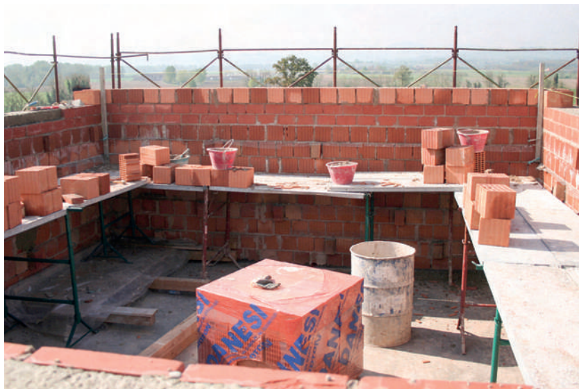
La conformazione della muratura armata e il cordolo in sommità della torre.
