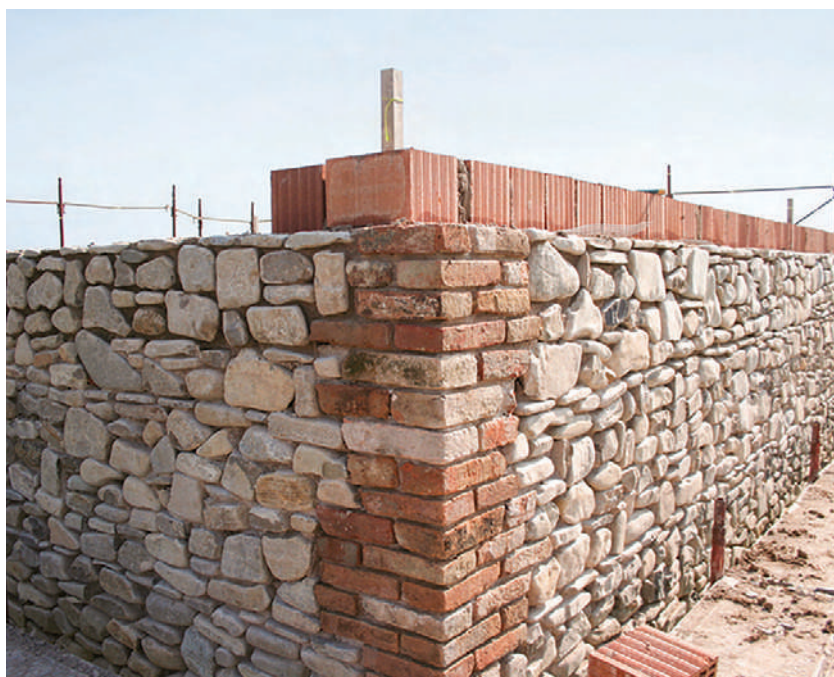
Il nuovo paramento esterno verticale con pietre sbazzate e laterizio cantonale.
