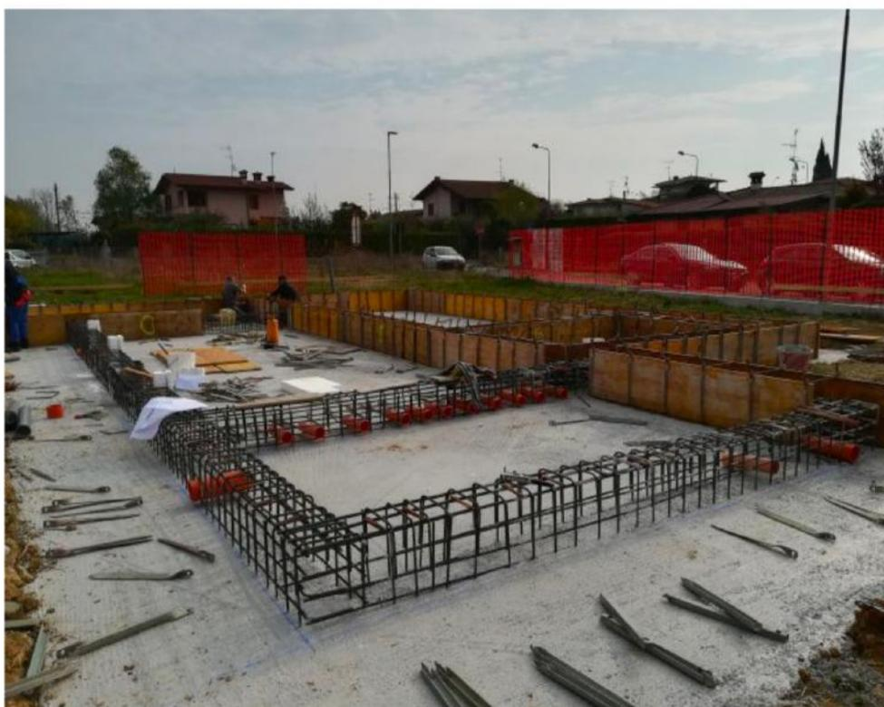
Per la realizzazione dell'immobile, che si trova in zona sismica 2, si è scelta una fondazione a platea in calcestruzzo armato, struttura in elevazione in muratura armata, solaio di piano in legno lamellare su cordolo perimetrale in calcestruzzo armato e una copertura in legno lamellare su cordolo perimetrale in calcestruzzo armato.
