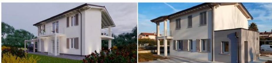
L'edificio, ricadente in **zona sismica 2** (pericolosità sismica media) è stato realizzato attraverso una fondazione a platea in calcestruzzo armato, **struttura in elevazione in muratura armata**, solaio di piano in legno lamellare su cordolo perimetrale in calcestruzzo armato e una copertura in legno lamellare anch'essa su cordolo perimetrale in calcestruzzo armato.
