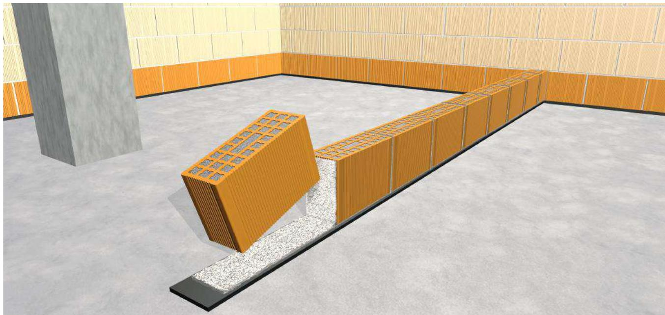
Applicata un'adeguata guaina impermeabilizzante dove richiesto, posare il corso di **blocchi Normablok Più** realizzando i giunti con malta di allettamento tradizionale.
