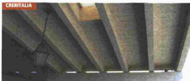
■ **Creritalia punta su Coconut**, sughero spruzzato eco-performante costituito da una miscela in sughero e resine a base acqua. La soluzione è ideale per proteggere le facciate esterne degli edifici in sostituzione della tradizionale rete-rasatura. È possibile utilizzare il Coconut anche per la protezione di pareti in legno e lamiera. Idrorepellente e traspirante il prodotto si presenta come un intonaco spugnato alveolato.
