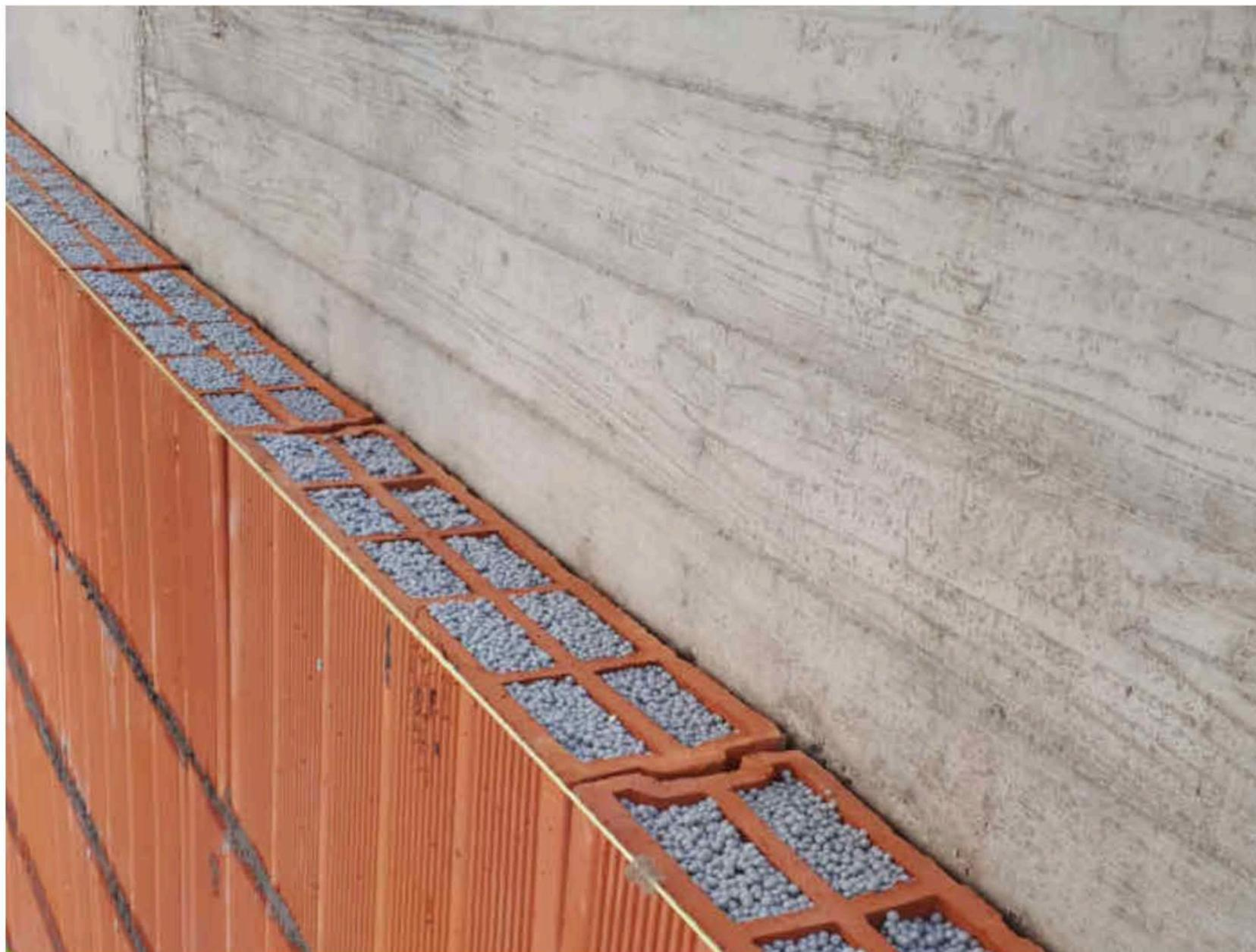
In **abbinamento** ai blocchi Normablok Più Ponti Termici, è infine possibile realizzare le restanti tamponature con **Normablok Più High Performance**, rendendo inutile l'applicazione di un cappotto termico.
