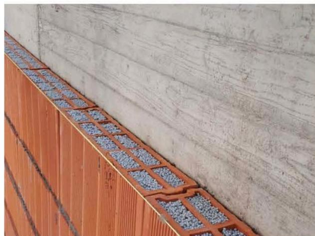
Normablok Più Ponti Termici è una linea completa di forati e tramezze ad alte prestazioni termiche concepiti per la **correzione dei ponti termici di pilastri e travi**. Le elevate prestazioni termiche sono garantite grazie all'iniezione di polistirene espanso caricato con grafite Neopor® di BASF ad alte prestazioni.
