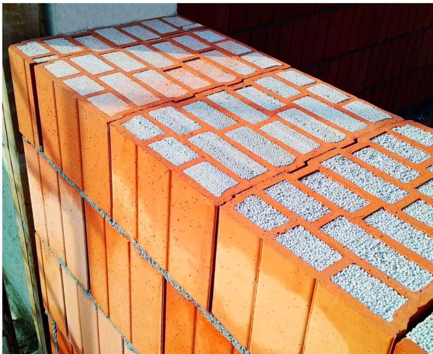
*Il blocco per tamponature monostrato in laterizio Normablok Più S40 Hp di Fornaci Laterizi Danesi ad alte prestazioni termiche è concepito per realizzare murature sicure anche sotto il profilo sismico.*
