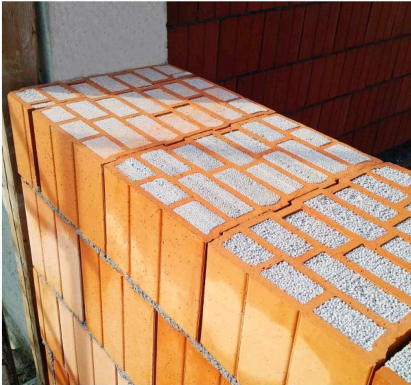
Il sistema Normablok Più S40 HP ha ottime caratteristiche d'isolamento termico.
