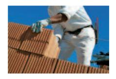
tre, come ultima fase del processo produttivo, all'interno delle cavità dei blocchi viene sinterizzato del polistirene additivato di grafite. Da questo elaborato processo produttivo nasce il sistema Poroton PlanTS8 che permette di realizzare pareti monostrato, intonacate tradizionalmente, capaci di elevati valori di isolamento e inerzia termica, fondamentali per garantire la realizzazione di edifici a basso consumo energetico.
