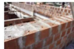
Poroton: setti sottili per muratura portante in zona sismica
