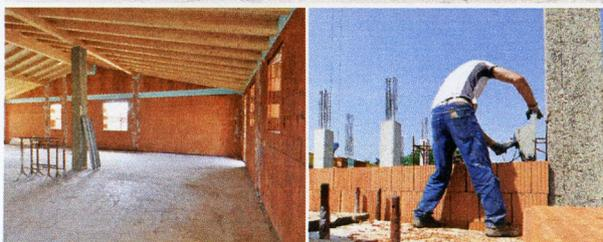
**Il Sistema Plan, e in particolare i nuovi blocchi a setti sottili, ha risposto ai requisiti di isolamento termico, semplicità d'uso e velocità di posa richiesti dal team di progettazione e dall'impresa costruttrice.**
