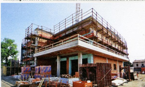
In primo piano la realizzazione di murature monostrato utilizzando blocchi rettificati a setti sottili Poroton plan ts.
